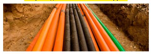
Строительство различных объектов требует реализации многочисленных силовых и слаботочных кабельных линий. Для надежности их функционирования используют прокладку кабеля в трубах.
