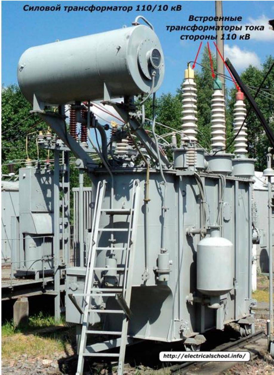
Для ОРУ выпускают трансформаторы тока типа ТФН в фарфоровом корпусе с бумажно-масляной изоляцией и каскадного типа ТРН. Для релейной защиты имеются специальные конструкции. На выводах масляных баковых выключателей и силовых трансформаторов напряжением 35 кВ и выше устанавливаются встроенные трансформаторы тока. Погрешность их при прочих равных условиях больше, чем у отдельно стоящих трансформаторов.
