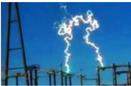
Рисунок 39 – Образование коронных разрядов на высоковольтной линии ( http://www.15mscience.org )
