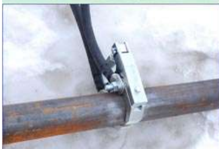
Рисунок 66 – Электрообогрев металлического трубопровода ( http://www.gerset.ru/article/372/50/ )
