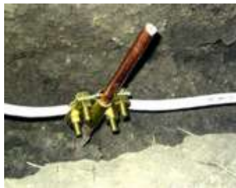
Рисунок 69 – Установка заземлителя
