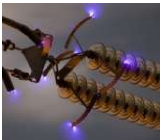
Рисунок 39 – Образование коронных разрядов на высоковольтной линии ( http://www.15mscience.org )
