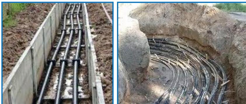
Рисунок 46 – Прокладка кабельных линий в земляных и каменных траншеях с подсыпкой снизу
