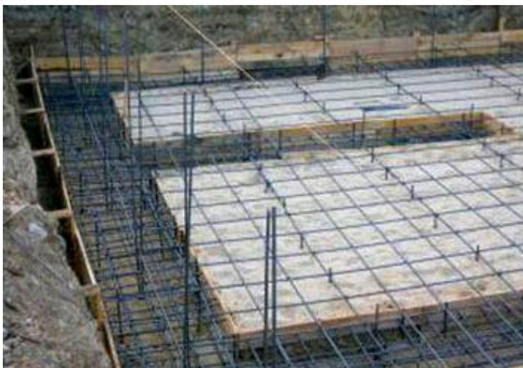
Рисунок 63 – Прогрев бетона электродами в зимних условиях
