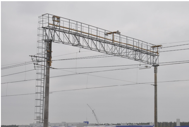
Рисунок А.14 – Установка осветительных приборов на ригелях жестких поперечин
